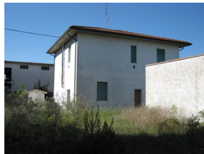
Figura 50. Fabbricato A - palazzina uffici e abitazione del custode. Edificio in muratura e cemento armato originariamente costituito dal solo piano terra, poi oggetto di un intervento di sopraelevazione che ne ha determinato l'attuale consistenza di circa 98,00 mq a piano.
