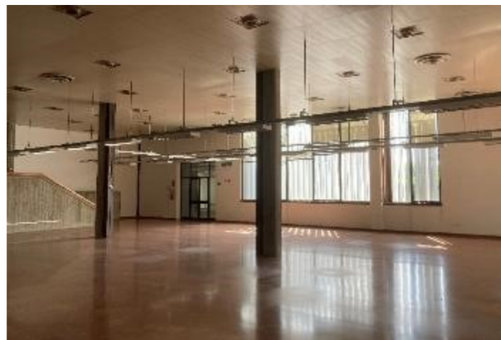
Figura 31. Foto Ed. Part. 11 Fonte: Foto Fonte: Regione Emilia-Romagna sopralluogo 2022
