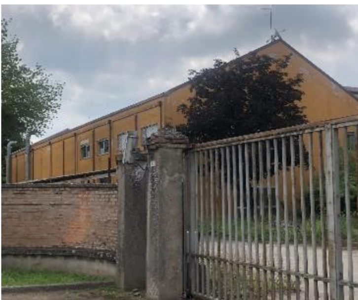
Figura 29. Foto Fonte: Regione Emilia-Romagna – sopralluogo 2022
