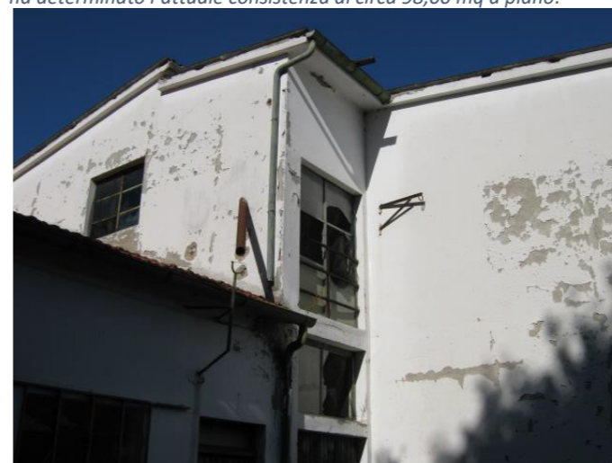
Figura 51. Fabbricato C - magazzini, locali allevamento, spogliatoi, servizi, mensa. Edificio in muratura di mattoni e solaio in laterocemento con manto di copertura in cotto, costituito da tre corpi di fabbrica per una superficie complessiva di circa 735,00 mq al piano terra, 560,00 mq al piano primo.
