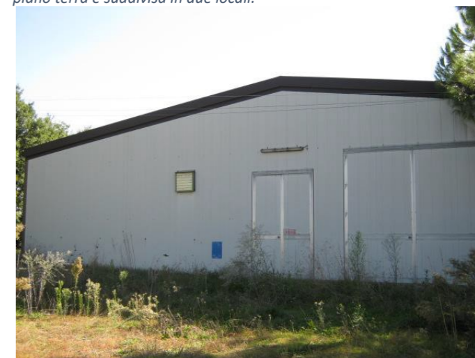
Figura 54. Fabbricato D - capannone zootecnico. Costruzione con struttura portante in acciaio, costituita da pilastri e travi reticolari con arcarecci di copertura, il tutto opportunamente coibentato e tutt'ora in buono stato di conservazione, per una superficie lorda complessiva di circa 1.680,00 mq
