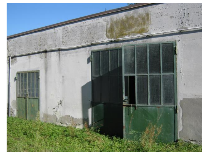
Figura 53. Fabbricato B - cantina e ricovero attrezzi. Piccolo edificio costruito in muratura di mattoni con copertura piana in laterocemento, della superficie lorda complessiva di circa 75,00 mq, disposta sul solo piano terra e suddivisa in due locali.
